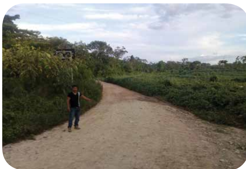
Foto 2. Camino a ser mejorado con el Proyecto priorizado
